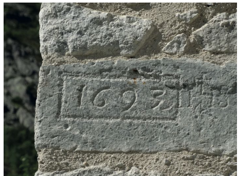
Détail d'un mur de l'église de Vallorcine
