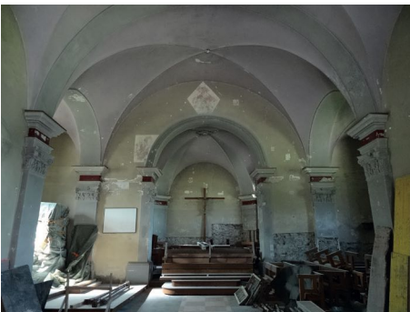
Travaux de restauration en cours à l'église de Vallorcine, soutenus par l'association par un montant de 500 euros
