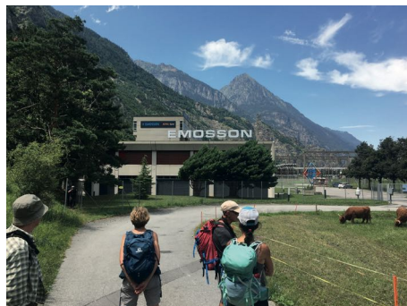
L'usine d'Emosson à la Bâtiaz à proximité de l'ancien village d'Ottan
