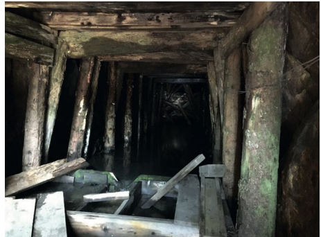
Entrée d'une galerie ennoyée sous Méreune
